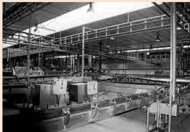
Interior de la fábrica de aceitunas Acyco, en Dos Hermanas.
